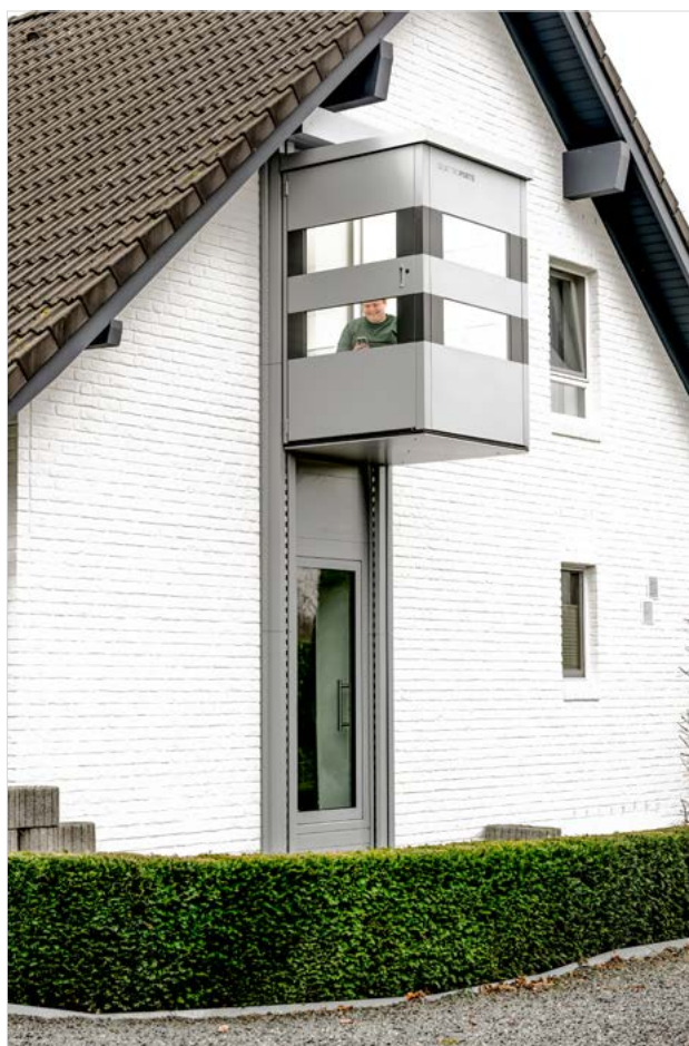
Mit dem Außenaufzug kann Lukas zwischen den beiden Etagen des Einfamilienhauses wechseln.
