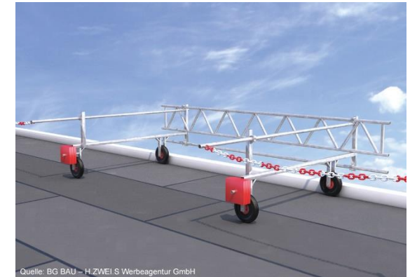
Schutzmaßnahmen gegen Absturz bei Arbeiten an der Dachkante
